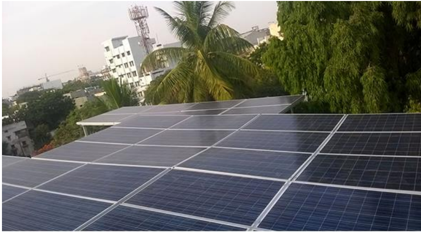
10 KW PV Array
